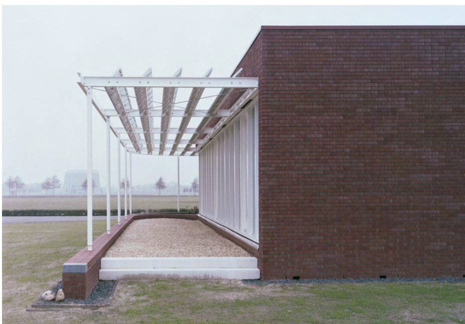
stalen pergola met zonnepanelen
